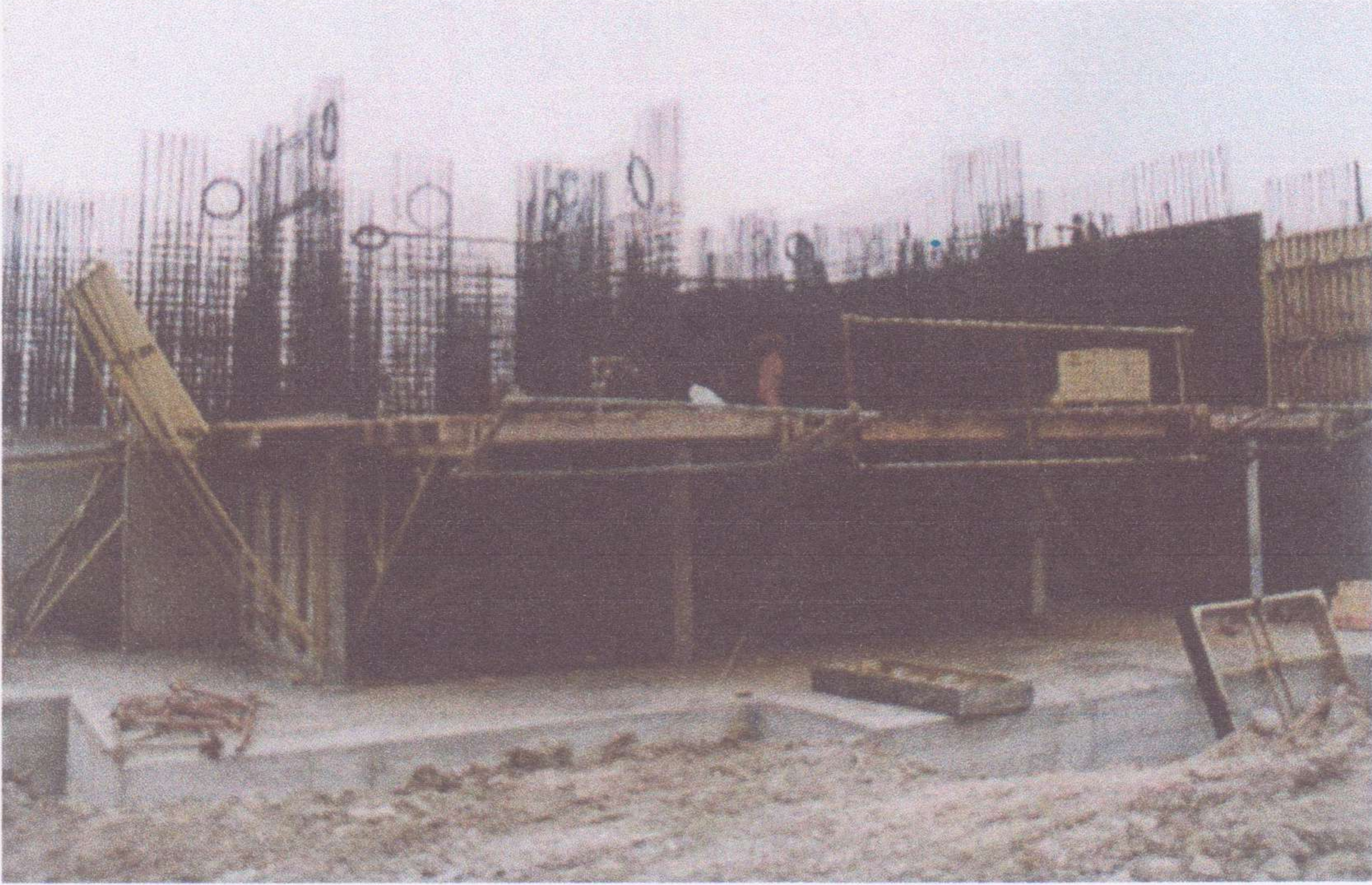
Şekil 3.3. İnşaattan radyetemel uygulaması
