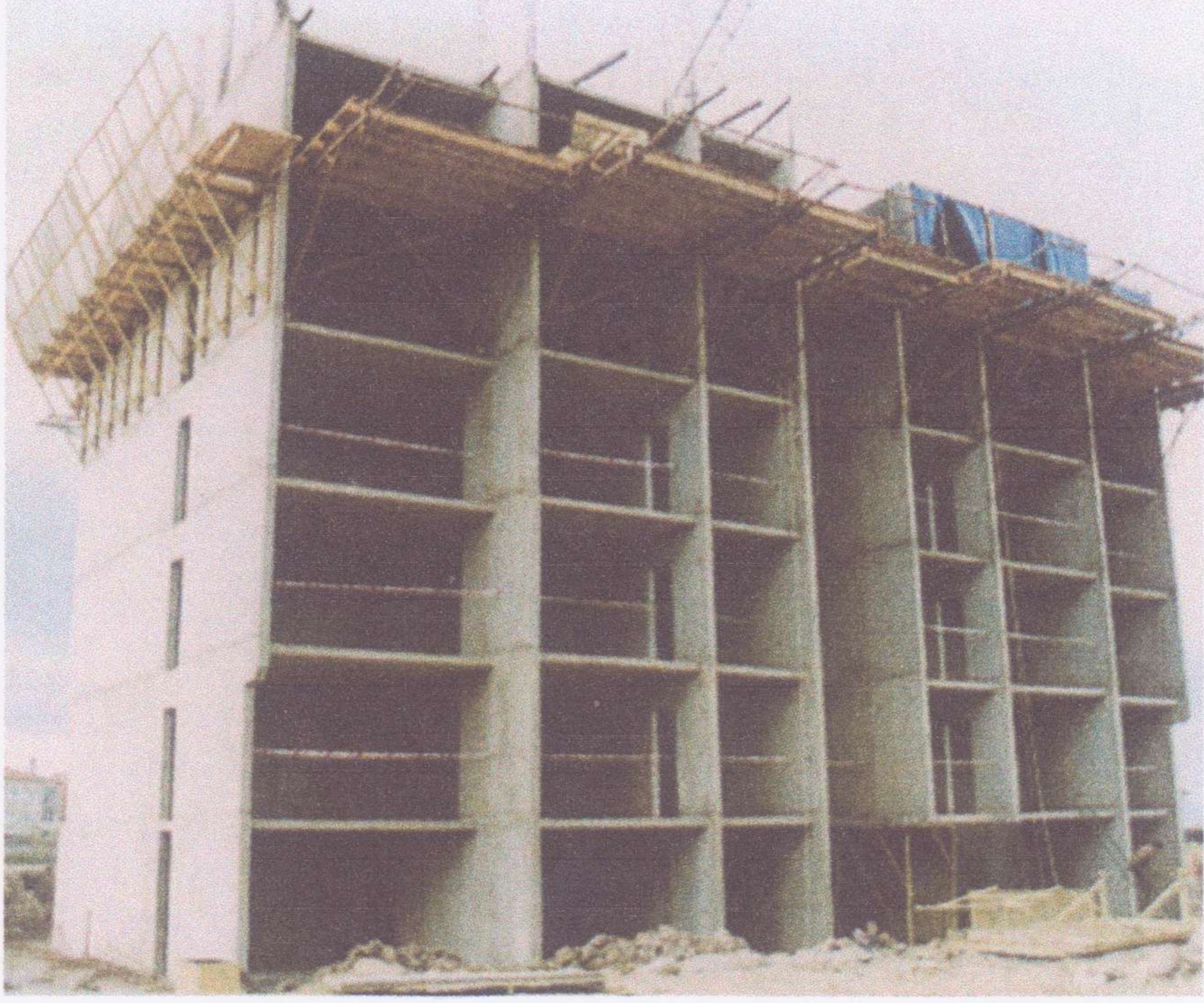
Şekil 3.1. İnşaattan perde duvar uygulaması
