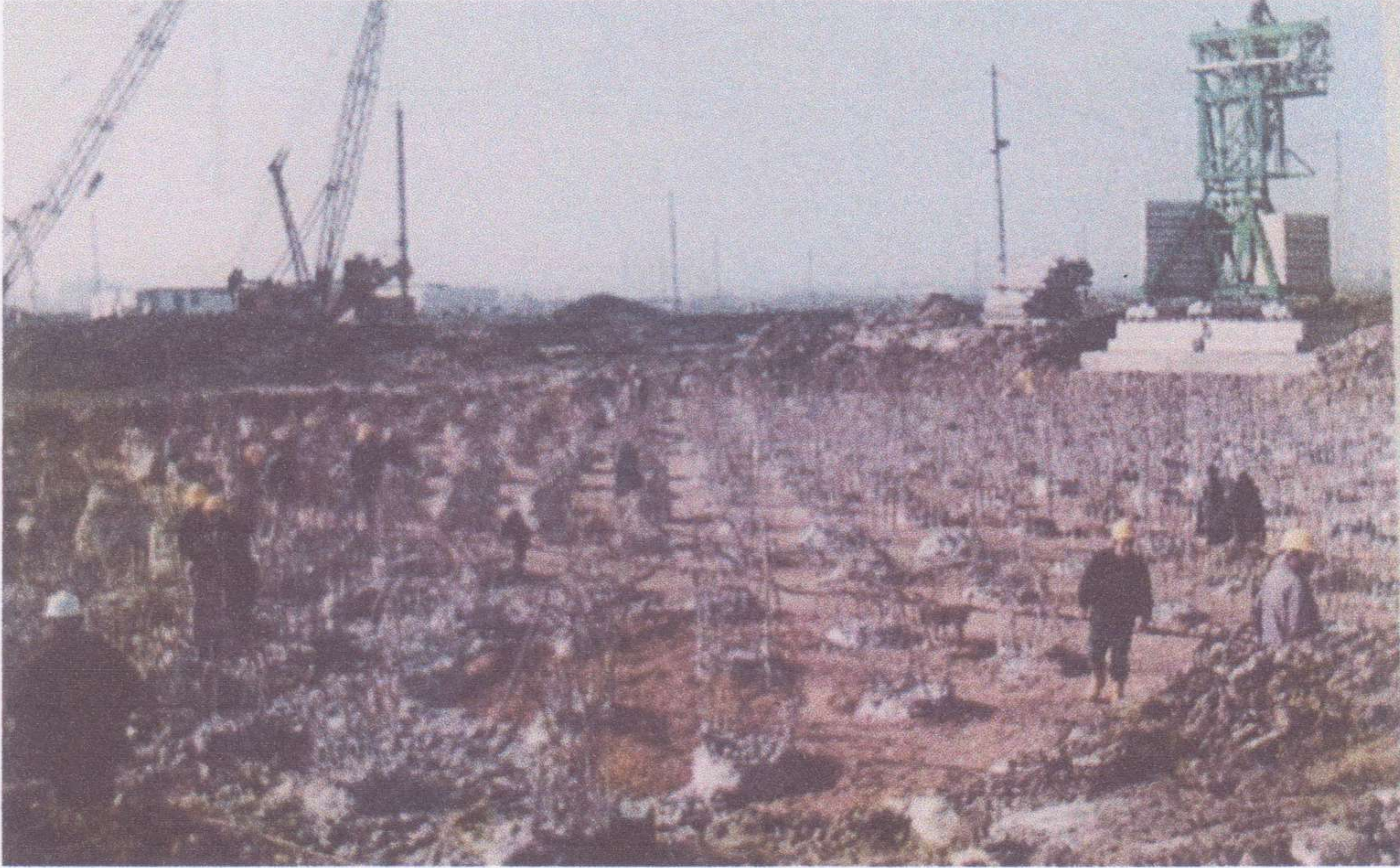
Şekil 3.2. İnşaattan fore kazık uygulaması
